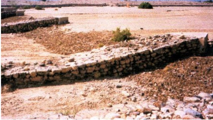
写真3 ロードコーヒー（洪水灌漑地区）の面積費分流取水堰 雨後の出水を面積比で取水する堰
