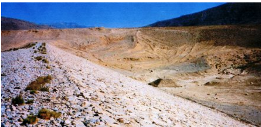
写真8 D.A.ダムの上流側堤体
