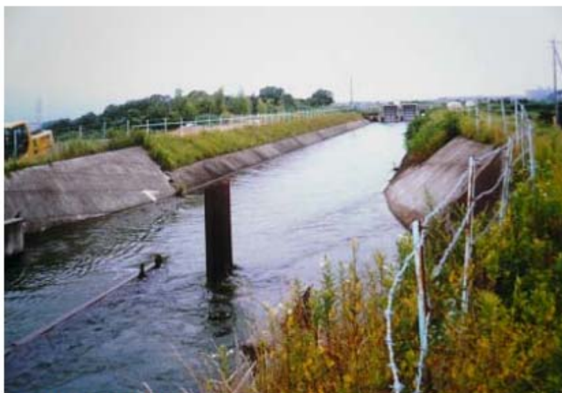
●当初の幹線水路と水位調節堰（後方）
