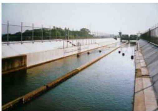
●二期後の幹線水路と水位調節堰
