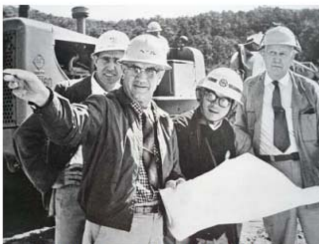
● F E A 技術者による大型機械施工の巡視
